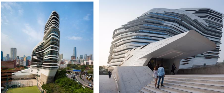
Рис.1. Политехнический университет в Гонконге.
