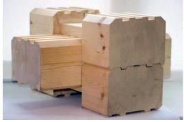
18. На рисунке представлено соединение двух одинаковых элементов бруса. На торцевом срезе каждого образца виден разный текстурный рисунок отдельных элементов материала. Напишите точное название такого бруса.
