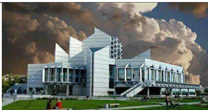
2. Здание общественно-культурного центра
